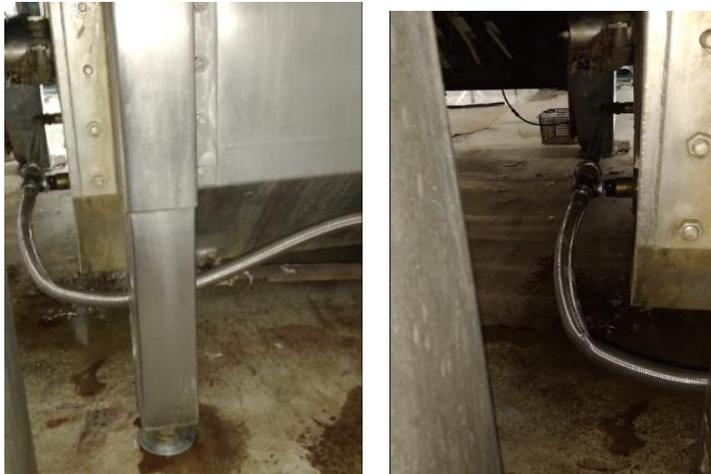
Se acondiciona manguera para interconexión tubería rígida y tanque de escaldado, minimizar vibración del sistema
