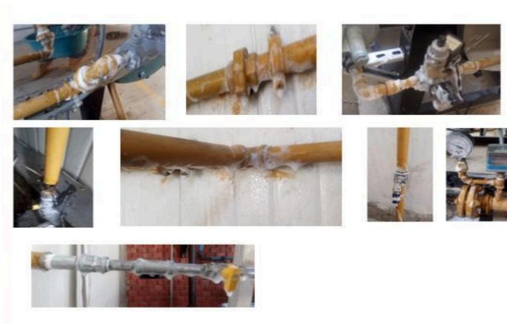
Los sistemas de roscas, uniones, universales y válvulas de la tubería, en caso de manifestarse efectos de burbujas en los elementos inspeccionados el siguiente paso es notificar y programar corrección de la falla y es realizado por personal experto y certificado para tal fin.
