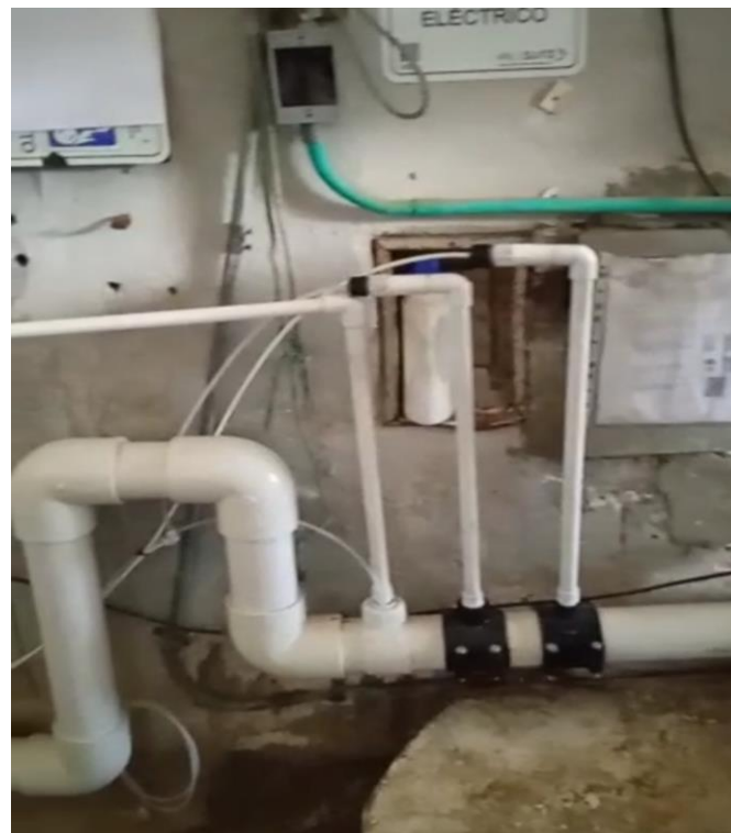
IMAGEN No. 3. Modificación a instalación de inyectores de químico en tubería principal.
