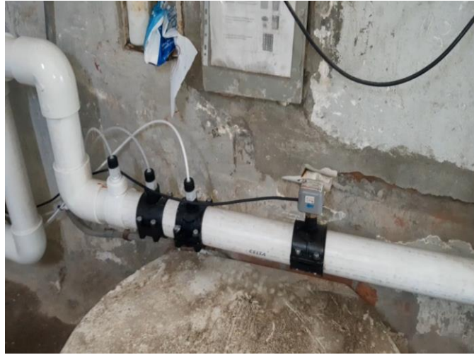
IMAGEN No.2. Instalación inicial de inyectores de químico en tubería principal.
