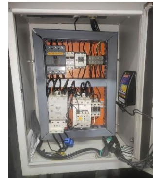
ASI QUEDO EL TABLERO ELECTRICO DE VISCERAS REUTILIZANDO COMPONENTES COMO CONTACTORES E INDEPENDIZANDO VISUALIZACION DE TEMPERATURAS
