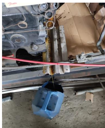
SE CAMBIARON FILTROS DE LIQUIDO Y DE SUCCION
