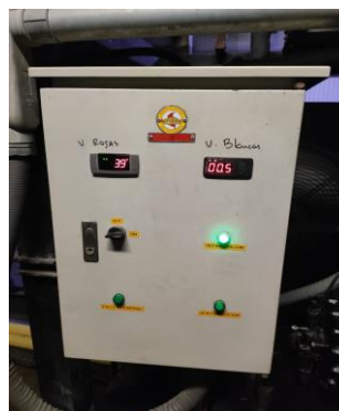
ASI QUEDO EL TABLERO ELECTRICO DE VISCERAS REUTILIZANDO COMPONENTES COMO CONTACTORES E INDEPENDIZANDO VISUALIZACION DE TEMPERATURAS
